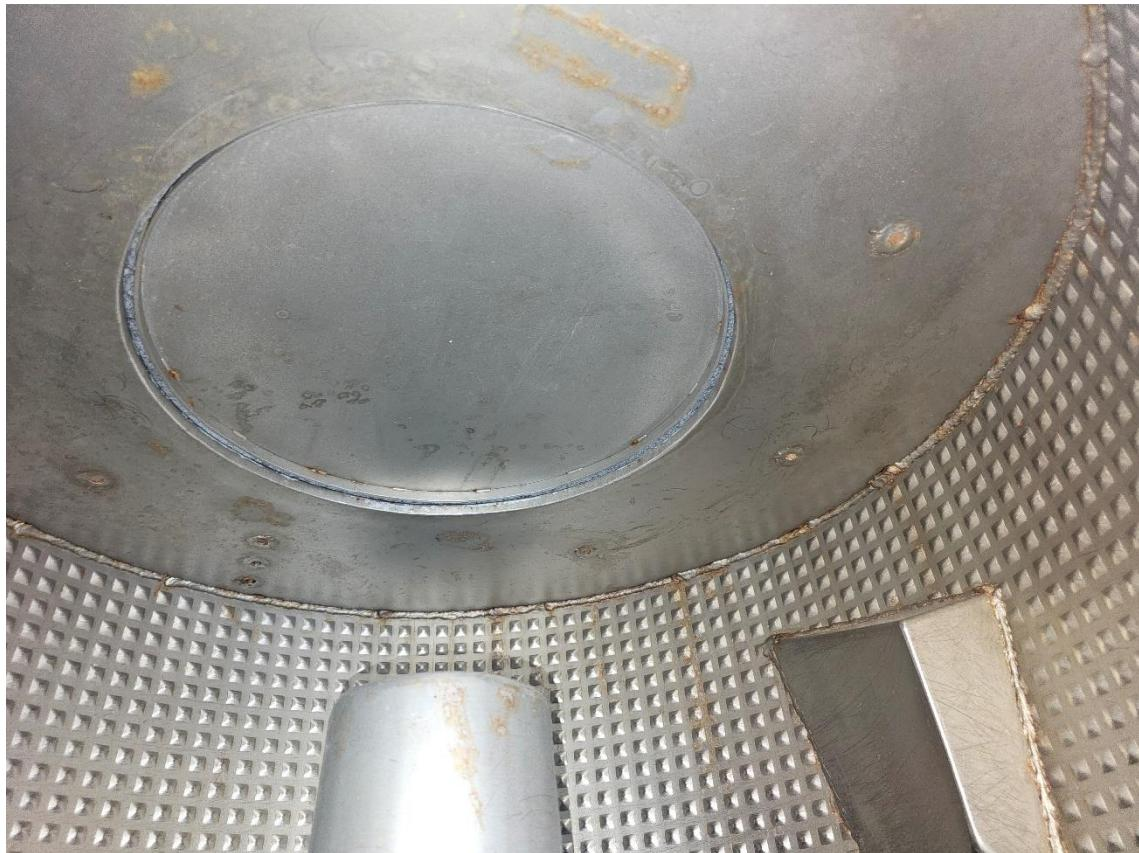
Dicho equipo presenta buen estado de conservación y mantenimiento, sin deterioro excesivo ni zonas con corrosión, sino pequeñas oxidaciones normales en este tipo de materiales con la antigüedad que presenta, las cuales pueden tratarse sin mayor dificultad y sin pérdida de funcionalidad.
